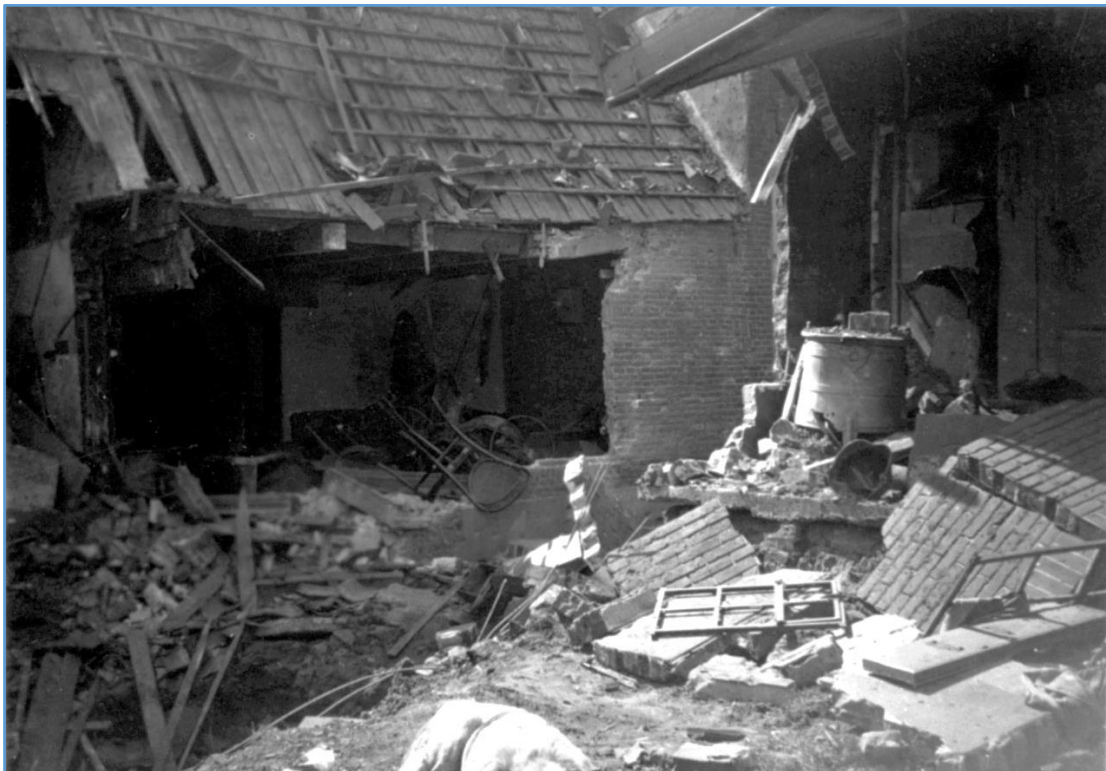
Schade aan en achter het huis van Riedé in de Kerkstraat
